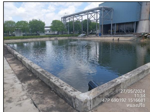
ภาพที่ 12 บ่อพักน้ำทิ้ง (Holding Pond)
