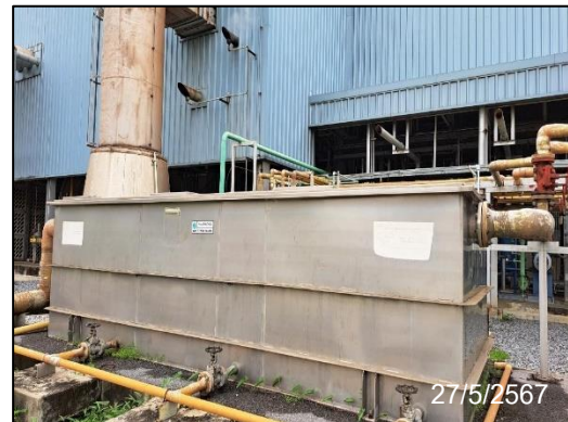
ภาพที่ 11 ระบบบำบัดน้ำเสีย (ระบบ Neutralization & Oil Separator)
