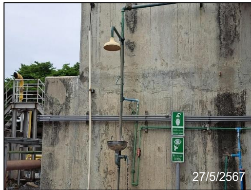
ภาพที่ 1 ที่ล้างตา มือ หน้า และฟีกบัวชำระล้างร่างกายจากสารเคมีอันตราย
